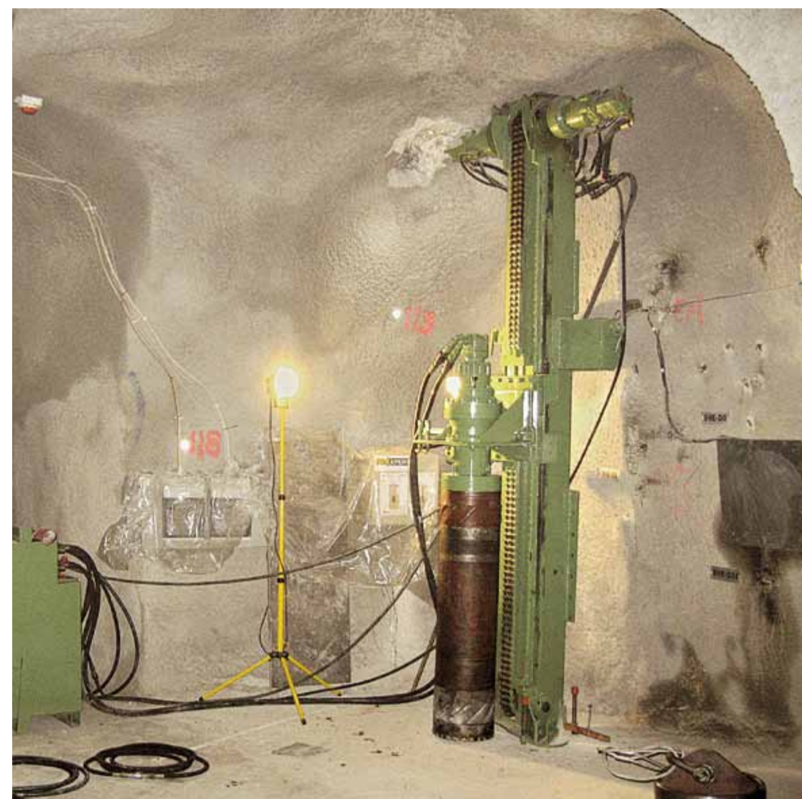
Bohrung (Durchmesser 300 mm)
