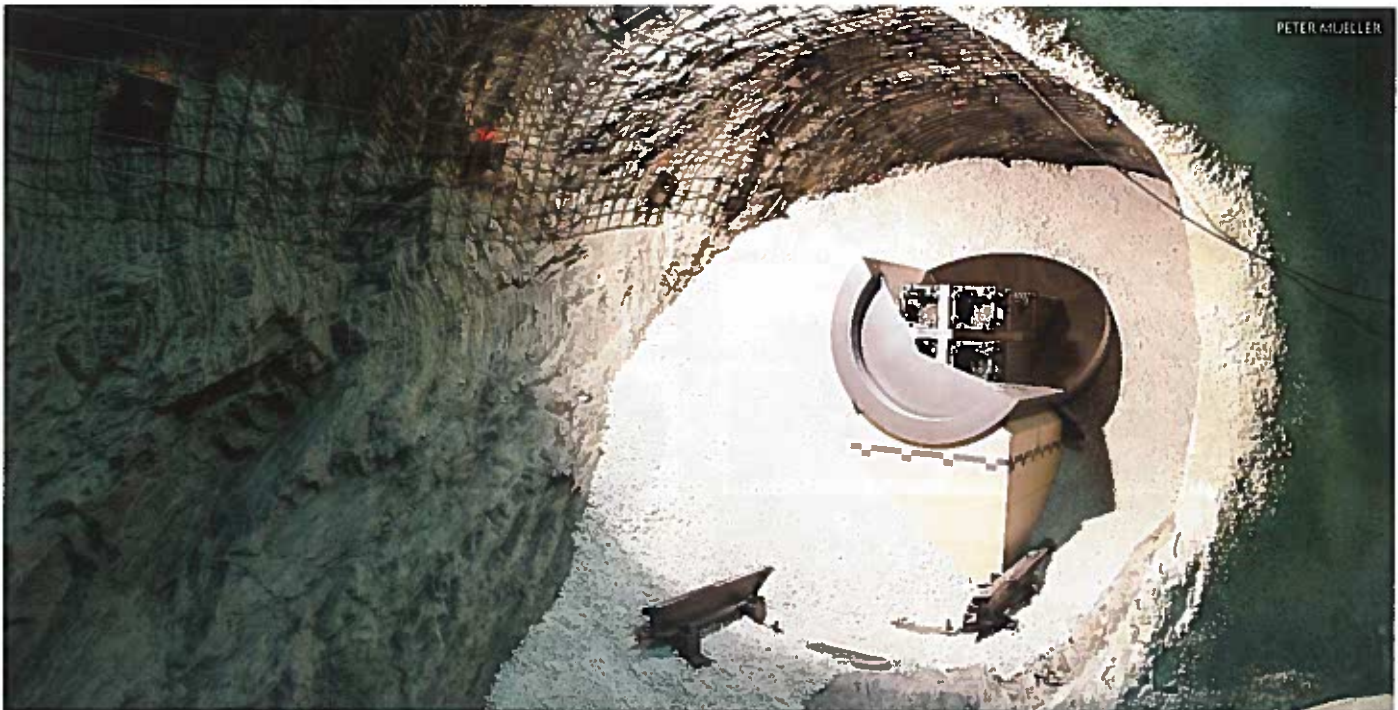
Maquette explicative pour le grand public à l'échelle 1:1 d'un enfouissement de cylindre de déchets nucléaires.
