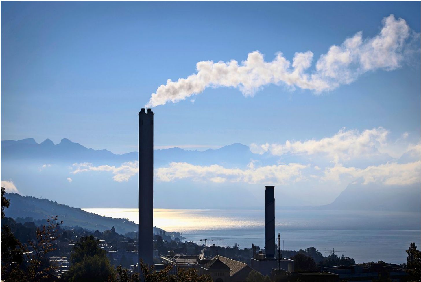
La cheminée de l’usine Pierre-de-Plan, chauffage à distance pour la ville de Lausanne (en liaison avec l’usine d’incinération de Tridel, dont elle valorise la chaleur), émet beaucoup de dioxyde de carbone qui pourrait être à terme capté, enfoui ou valorisé.
